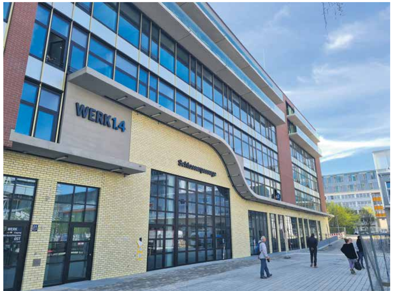
Werksviertel-Mitte, zglede prenove industrijskih zgradb Foto: Tomaž Kancler
